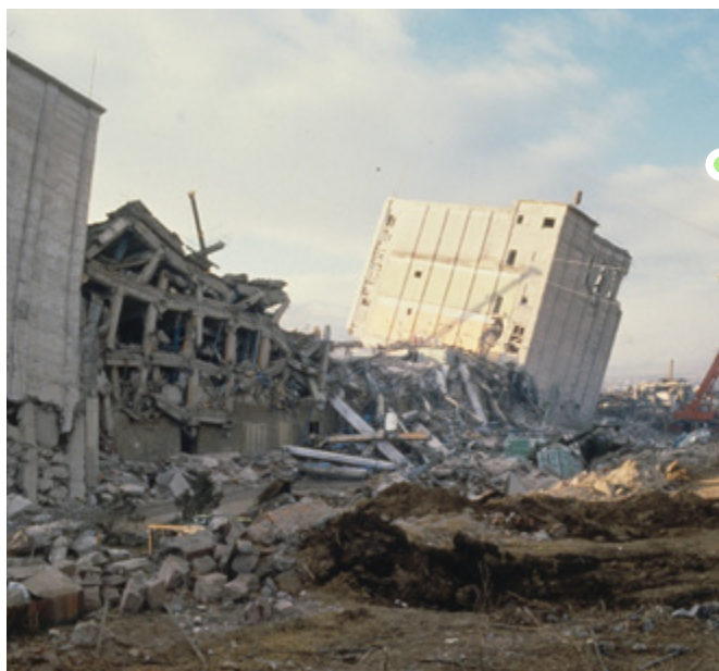
Destructions provoquées par le séisme de Spitak (Arménie), le 7 Décembre 1988. © Hervé PHILIP / CNRS Images
